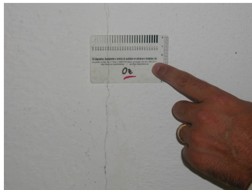
Fig. 3 – Utilização do comparador de fissuras para medição da abertura.
